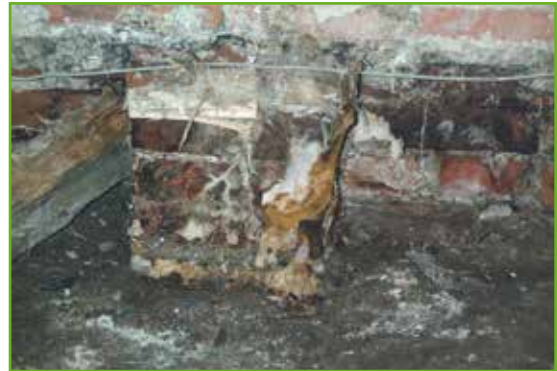
Homeen muodostuminen ja rakenteiden vaurioituminen.
