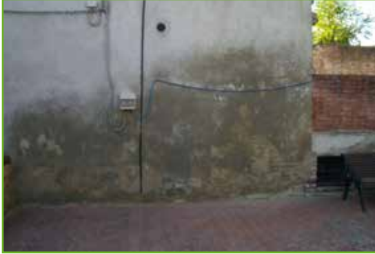
Värin muutos, lämmöneristyksen alentuminen.
