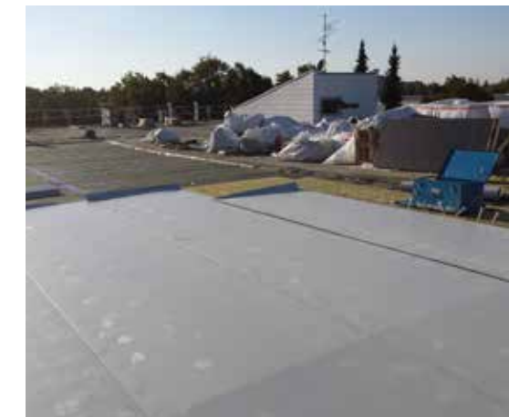
Tasakaton vedeneristys KÖSTER TPO:lla, EDEKA Supermarket, Saksa
