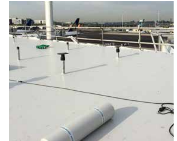
Tasakaton vedeneristys KÖSTER TPO:lla, Schiphol Lentokenttä, Amsterdam
