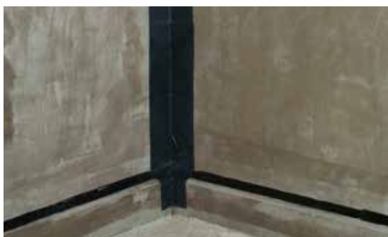
Tämän jälkeen päällyste asennetaan sisä- ja ulkokulmiin.
