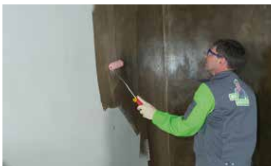
Alustan pohjustuksen jälkeen, viisteet asennetaan seinä/lattia liitokseen.
