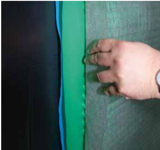
KÖSTER SD Levy 3–400 suojaa vedeneristystä ja mahdollistaa veden ohjauksen kuivatusjärjestelmiin
