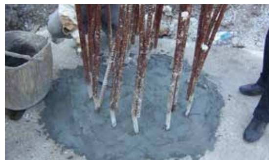
Asennetaan viiste ja tasoitetaan alue KÖSTER Korjauslaastilla
