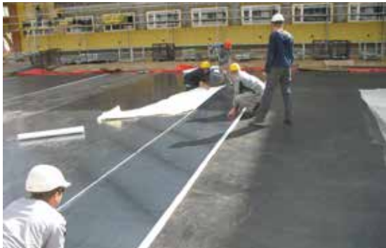
Vedeneristys KÖSTER KSK päällysteillä
