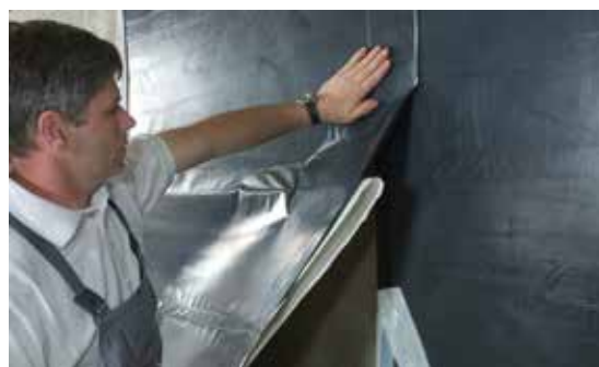
Alue vedeneristetään päällysteellä. Päällysteet tulee limittää n. 10 cm.
