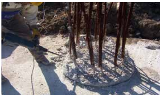
Poistetaan ulkonemat, puhdistetaan paalun pää
