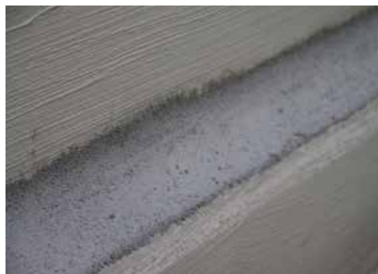
2. Viiste asennettu KÖSTER WP laastilla
