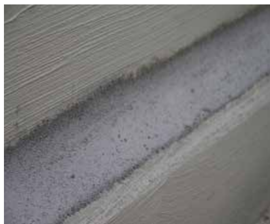
Kovera viiste seinä/lattia liitoksessa tehtynä KÖSTER Korjauslaastilla
