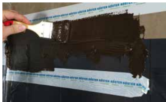
Päällysteen reunat tiivistetään KÖSTER KBE Neste-kalvolla.
