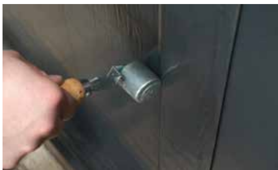
Käytä rullainta voimakkaasti painaen päällyste alustaan.
