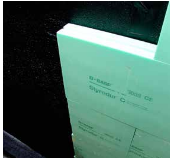
Lämmöneristyslevyt voidaan helposti kiinnittää kaksikomponenttisilla KÖSTER Polymerimodifioiduilla bitumipaksukalvoilla. On tärkeää että levyt on kokonaan liimattu.
