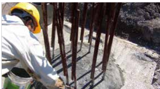
Paalu vedeneristetään KÖSTER NB 1 Harmaalla
