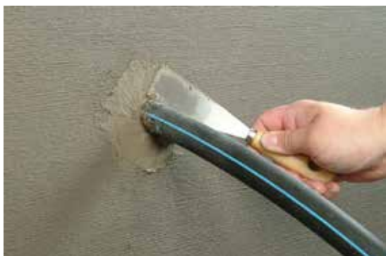
Putken läpivienti on nyt vedeneristetty. Tarkoituksena on suojata vedeneristystä, siksi alue putken tai kaapelin ympärillä tukitaan KÖSTER KB-Fix 5:lla.
