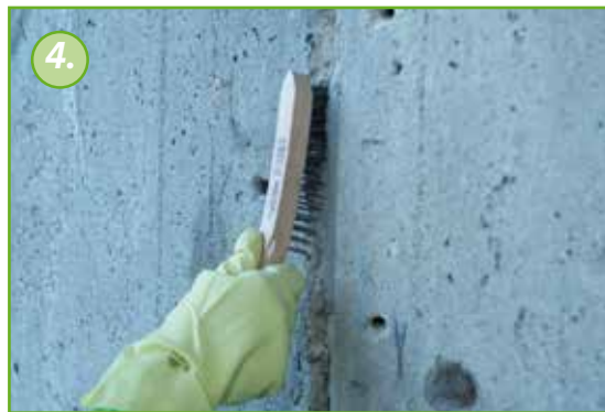
4. Putsaa halkeama käyttäen teräsharjaa.
