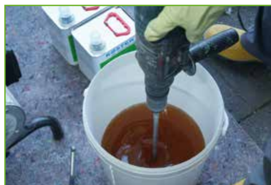
Käytetään sopivaa sekoitinta esim. KÖSTER hartsin sekoitustyökalua yhdistelmänä hitaasti pyörivän mekaanisen sekoittimen kanssa sekoittaen molem- mat komponentit. Komponentteja sekoitetaan kun- nes seos on homogeeninen.
