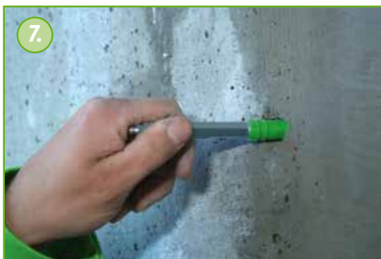
Asenna KÖSTER mansetit porausreikiin jättäen noin joka kolmas porausreikä avonaiseksi.
