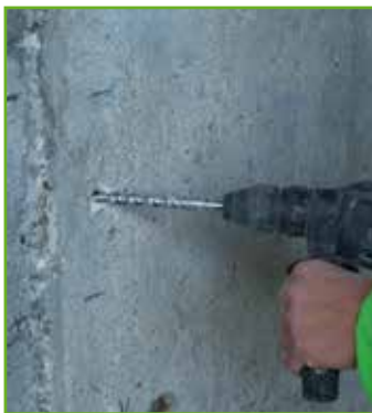
3. Reiät porataan halkeamaa kohti n. 45° kulmassa. Puhdista porausreiät paineilmalla tai vedellä.
