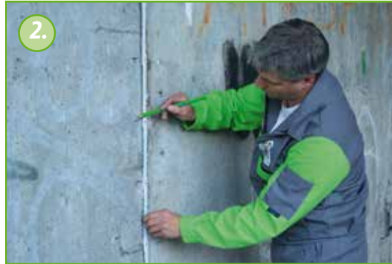
2. Merkkää paikat joihin porausreiät porataan. Porausreiät sijoitetaan pitkin halkeaman suuntaa molemmin puolin n. 10 cm–15 cm etäisyyksin toisistaan.
