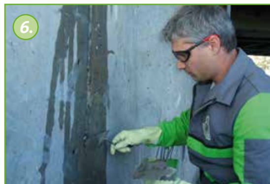
Sulje halkeama sen kulkusuunnassa KÖSTER KB-Fix 5 materiaalilla. Halkeaman sulkeminen ehkäisee injektointimateriaalin ennenaikaista valumista ulos halkeamasta injektoinnin aikana. Kovettumisaika on n. 5 minuuttia riippuen ympäröivästä lämpötilasta ja ilmankosteudesta.
