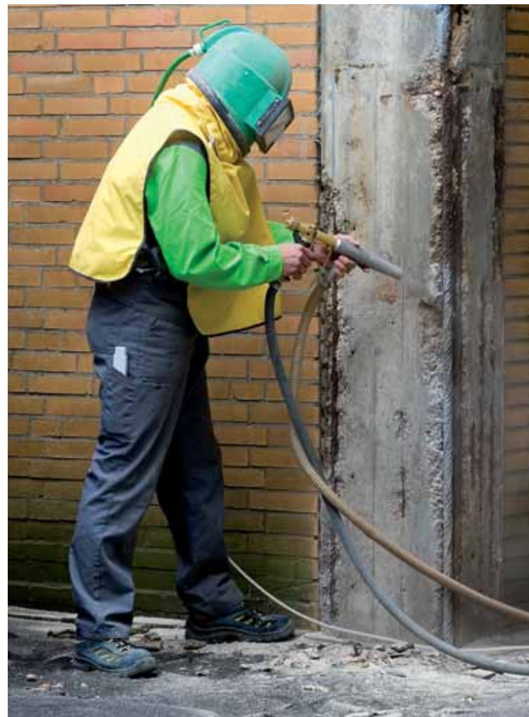
Betonin ja terästen puhdistaminen hiekkapuhaltamalla
