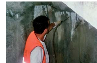
Injektointi käyttäen alhaista painetta
